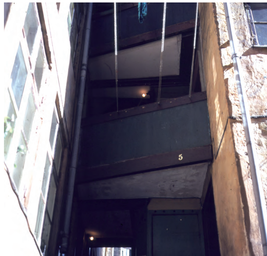
Trappehus i nr. 5, set fra nr. 7 i gården (1968). Huset tv. er forhus, huset th. er baghus. De træbyggede svalegange udgjorde en stor brandrisiko.
