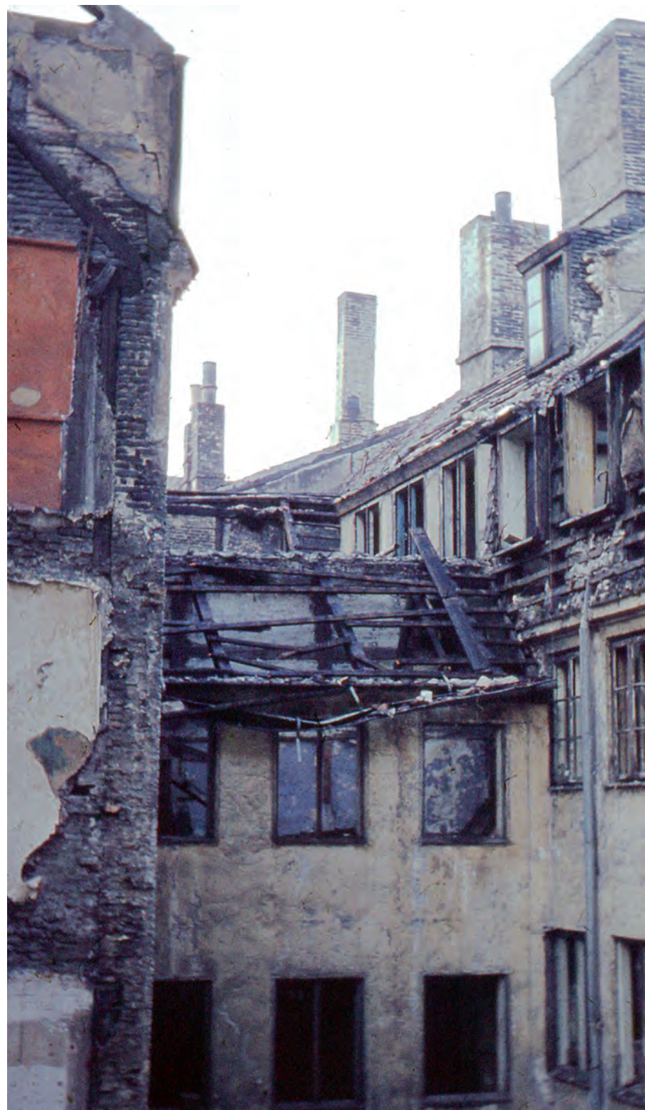
Huse under nedrivning tæt på Gothersgade (1962).
