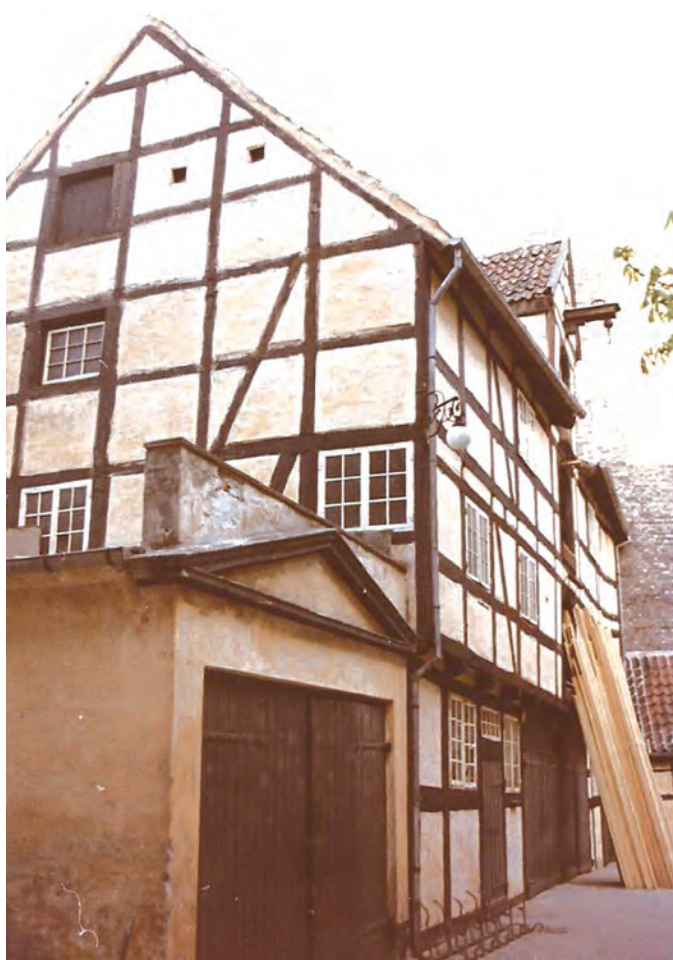
Den gamle fredede, nu istandsatte staldbygning i Baron Boltens Gaard (1966).
